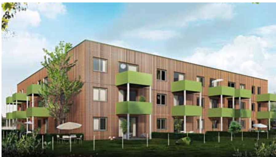
Bad Goisern setzt auf kostengünstiges und umweltfreundliches Bauen. Möglich ist dies durch Errichtung der Wohneinheiten auf einem Baurechtsgrundstück, das für die Dauer von 99 Jahren verpachtet wurde.
